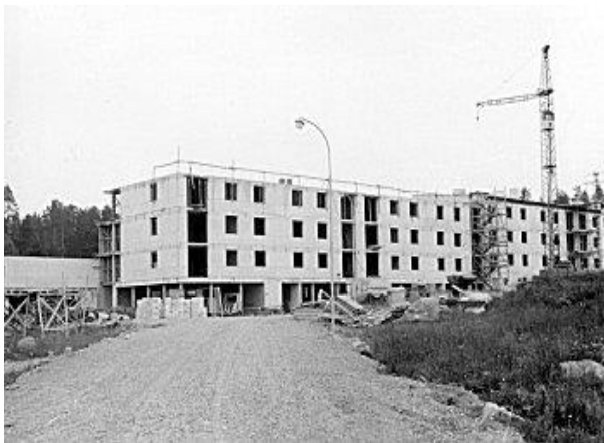
Bild från tidigt 60-tal. Vårt område under uppbyggnad
